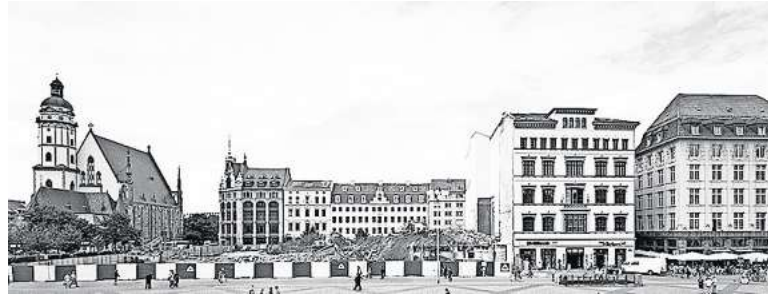
Der Markt im Juli 2001: In der Bildmitte ist die Baulücke nach dem Abriss des Messeamtes am Markt zu sehen.
