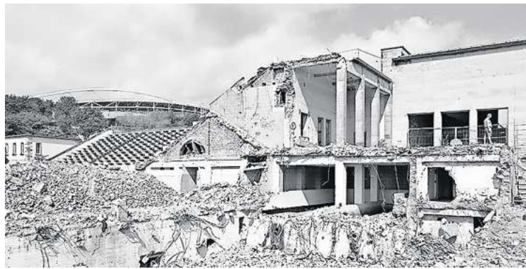
Friedrich-Ebert-Straße und Schwimmstadion im August 2004: Die in den 1950er-Jahren erbaute Schwimmarena wurde größtenteils abgerissen.
