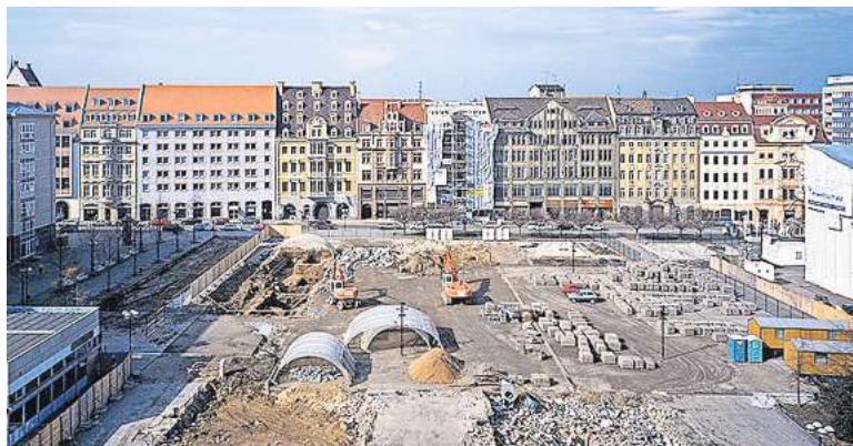
Böttchergäßchen und Katharinenstraße, März 1999: Die in der Bildmitte sichtbaren archäologische Ausgrabungen erbrachten neue Erkenntnisse über den großen Stadtbrand im 15. Jahrhundert.
